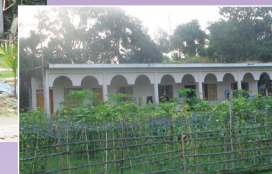
Bau des 2. Stockwerks beim Waisenhaus in Satbaria
