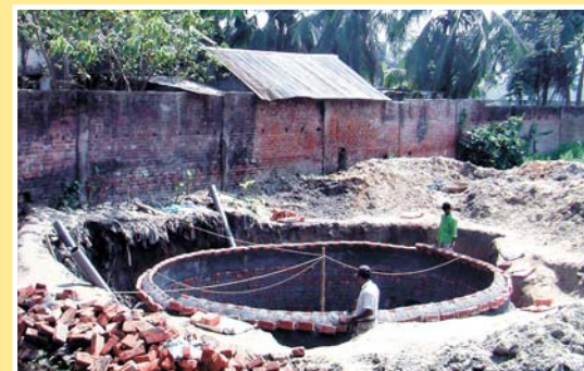
Bau unserer unterirdischen Biogasanlage
